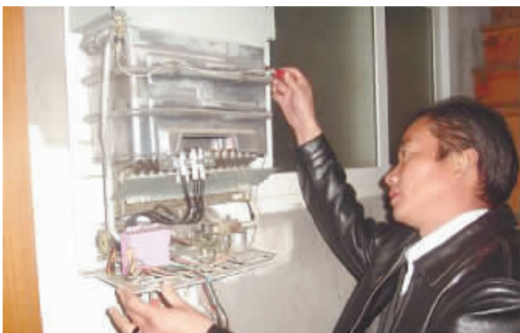
城北街道悦丰社区新市民服务队正在为居民维修服务。
